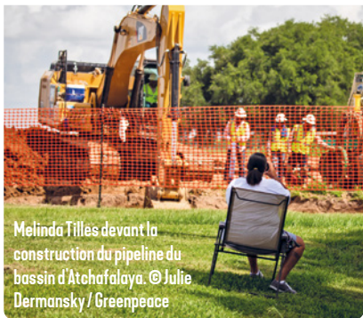
31 mars 2018, Acadia Parish, Louisiane. Construction de l'oléoduc Bayou Bridge. © Julie Dermansky / Greenpeace
