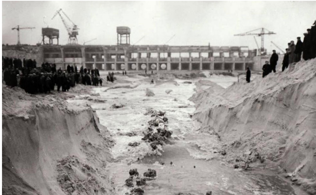
Зображення 14. Фото з будівництва греблі Київської ГЕС (початок 1960-х років). Автор: невідомий. Джерело: Укргідроенерго
