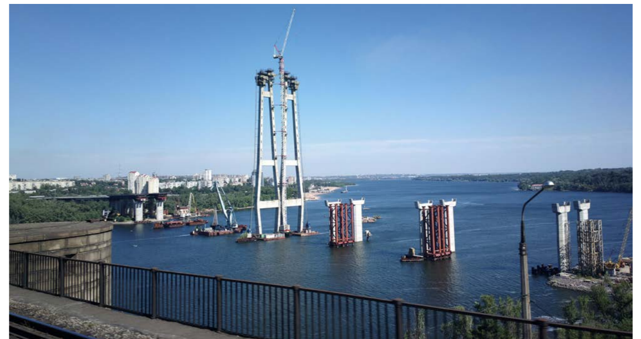
Зображення 16: Фото будівництва Нового мосту через Дніпро та Старий Дніпро у Запоріжжі, 2015 р. Автор: Тетеря Сонна; Джерело: Вікіпедія (CC BY-SA 2.0)
