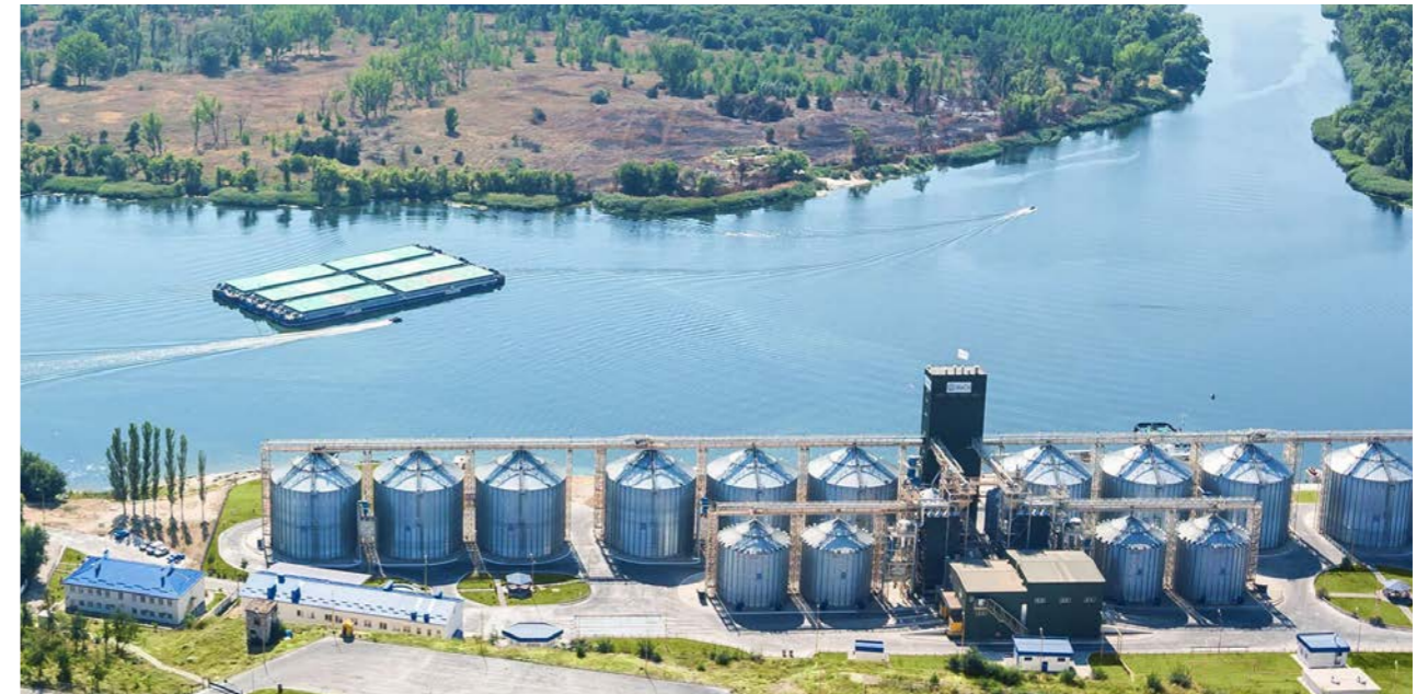
Зображення 6: Фото терміналу «Козацька» компанії «Нібулон» (Херсонська область). Введений в експлуатацію в липні 2012 року, призначений для зберігання і перевалки зерна та інших сільськогосподарських вантажів. У 2017 році потужності зі зберігання були розширені до 76 000 тонн. У 2023 році філія була повністю зруйнована і затоплена після руйнування росіянами Каховської дамби вище за течією. Автор: невідомий; Джерело: Нібулон
