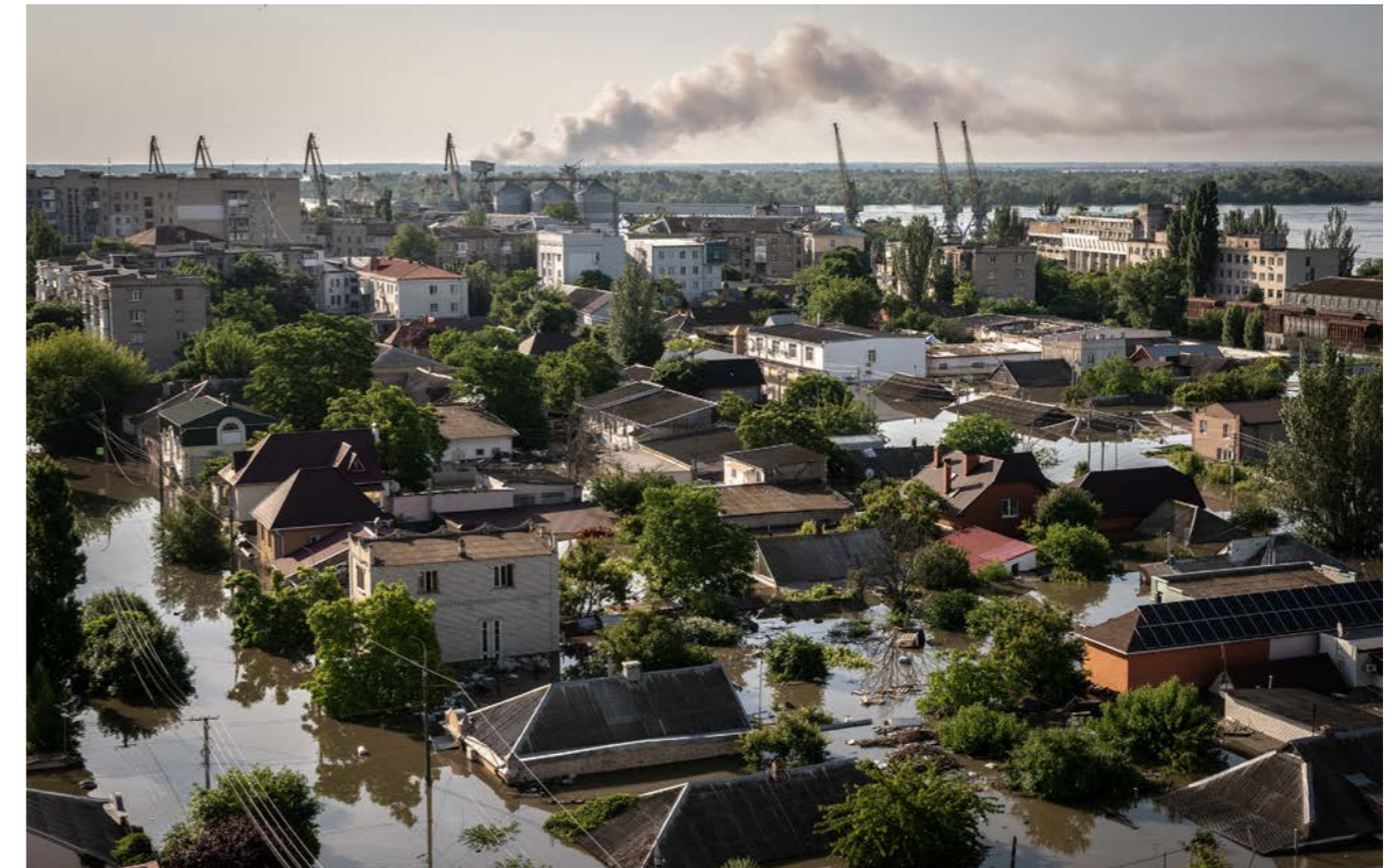
Зображення 9. Фото міста Херсон, затопленого водами Дніпра після руйнування Каховської дамби. Портові крани та елеватори на задньому плані також постраждали. Автор/джерело: Альона Будаговська.
