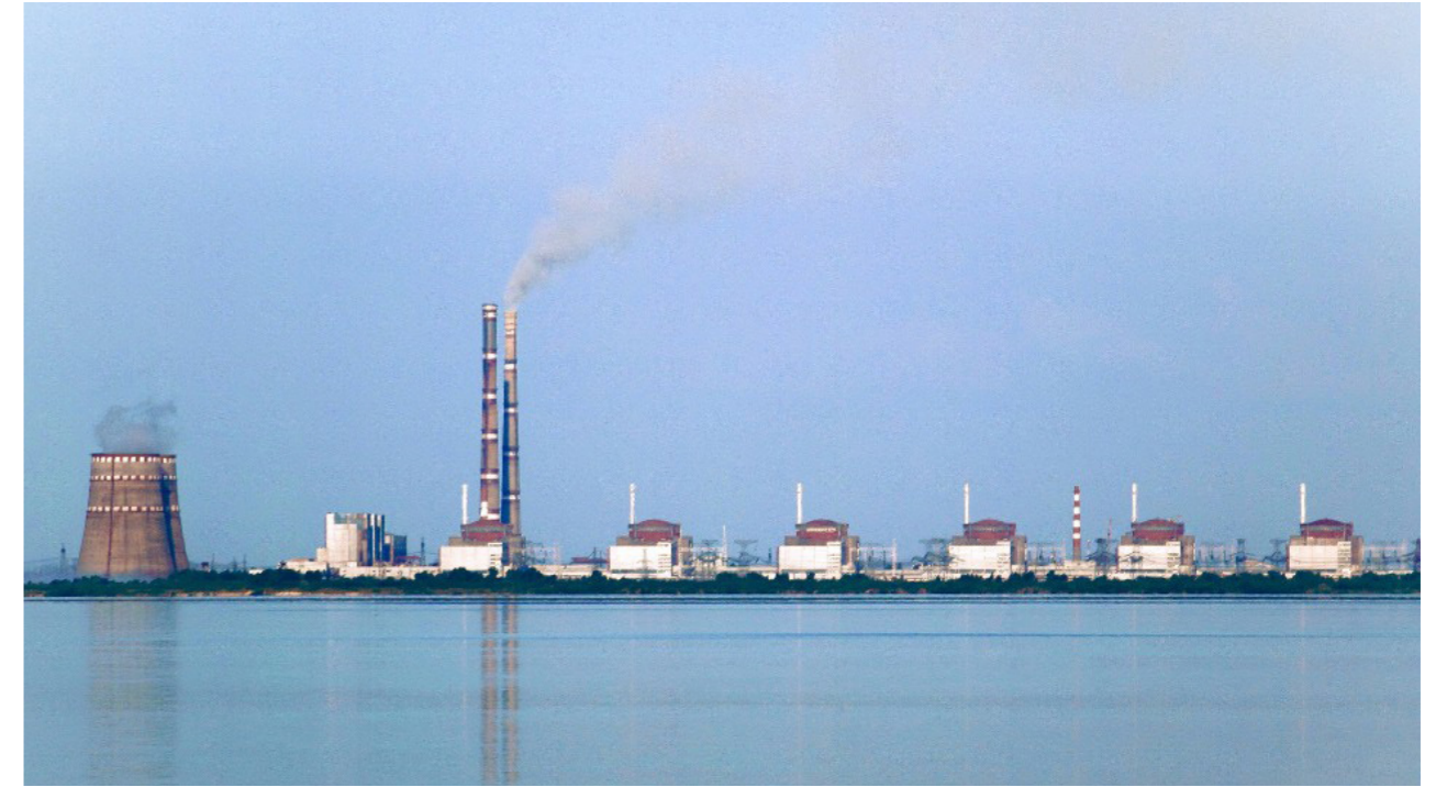
Зображення 5. Фотографія Запорізької атомної електростанції (2 градирні зліва та 6 реакторних корпусів ВВЕР) та Запорізької теплової електростанції (дві високі димові труби), вид з боку Каховського водосховища на річці Дніпро. Автор: Ralf1969; Джерело: Вікіпедія (суспільне надбання; CC BY-SA 3.0), 2009.
