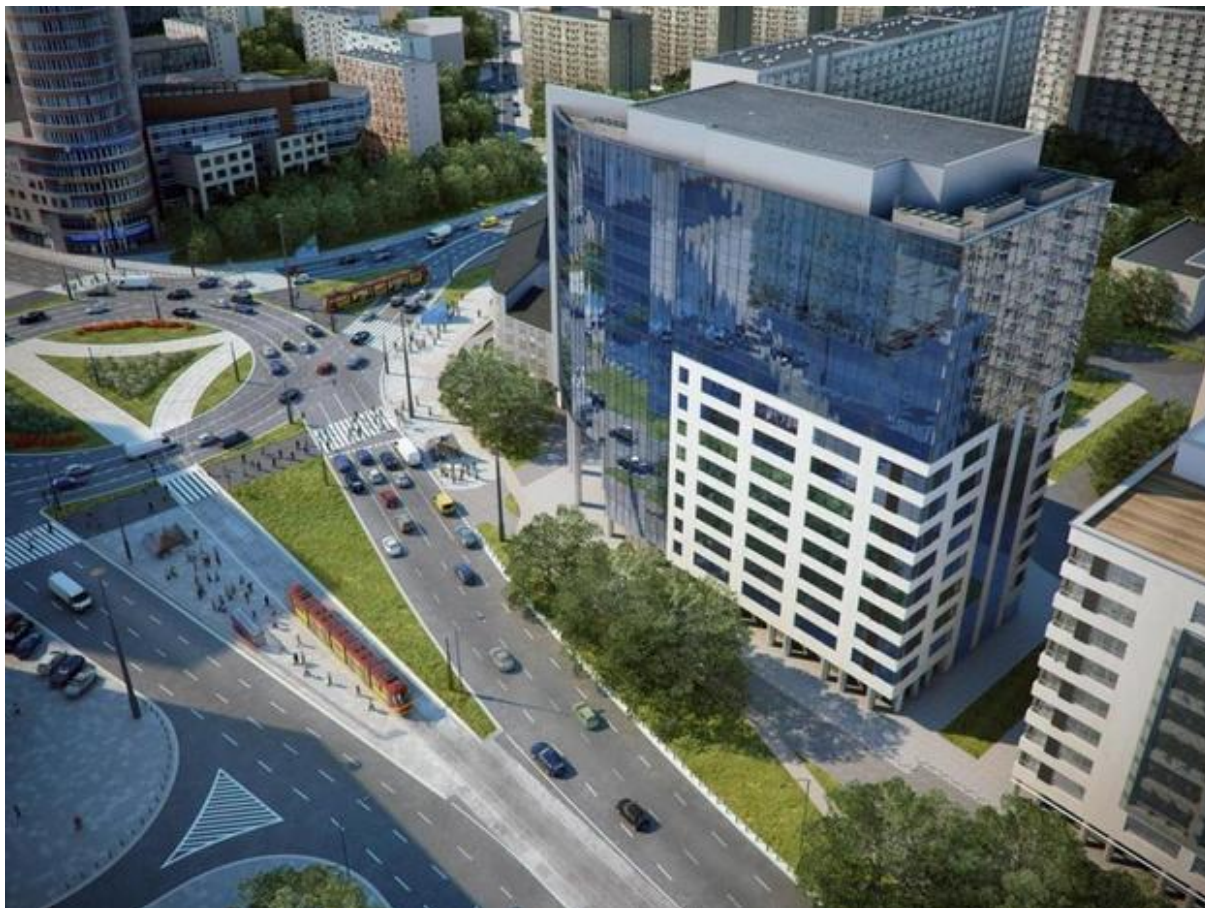
Rysunek 7 Budynek biurowy Atrium 1, Rondo ONZ, Warszawa, wyposażony w pompę ciepła, na fasadzie zielonego biurowca zainstalowane zostaną ogniwa fotowoltaiczne 25 .
