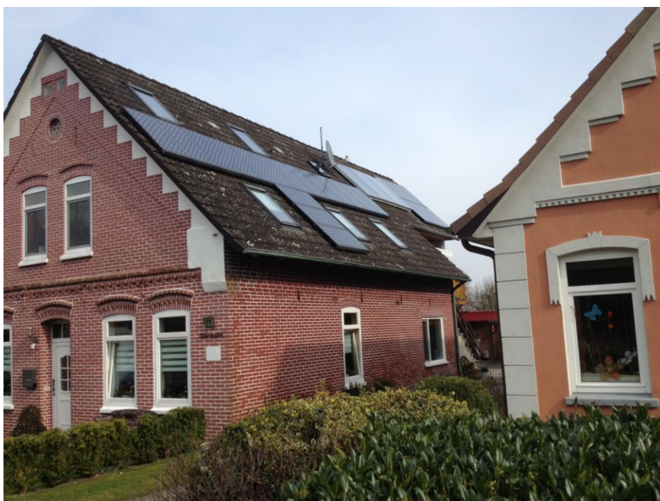
Rysunek 6 Instalacje prosumenckie na budynku jednorodzinnym: kolektory słoneczne i panele fotowoltaiczne. Fot. Anna Oniszk-Popławska.
