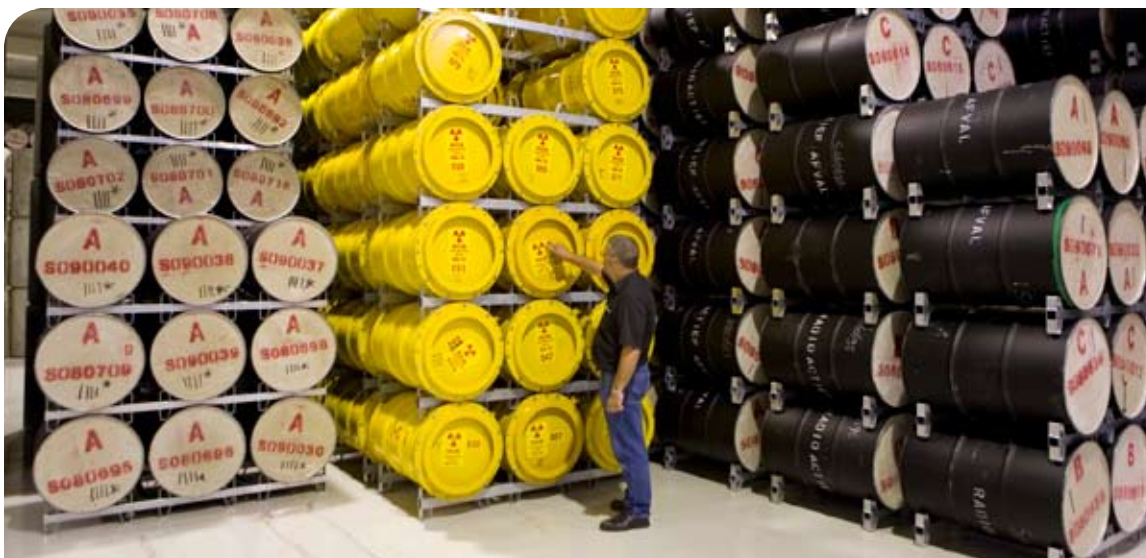
Tijdelijke opslag van radioactief afval bij Covra, Vlissingen.
