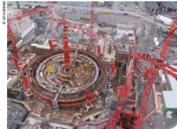
Olkiluoto, Finland: kerncentrale in aanbouw.
