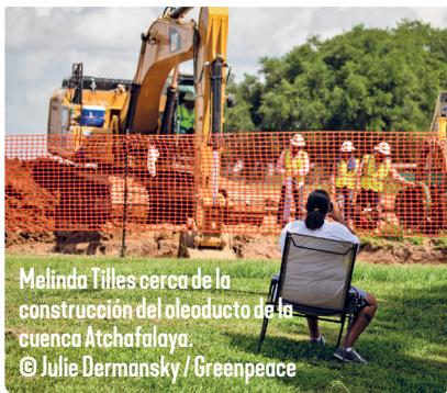
31 de marzo de 2018. Parroquia de Acadia, Luisiana. Construcción del oleoducto Bayou Bridge. © Julie Dermansky / Greenpeace
