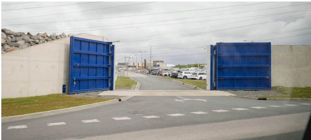
↑ Figure 7 : Les portes étanches permettant d'isoler les parkings attenants à la centrale nucléaire de Gravelines en cas de submersion marine ou d'inondation par les terres. @Greenpeace, 2024
