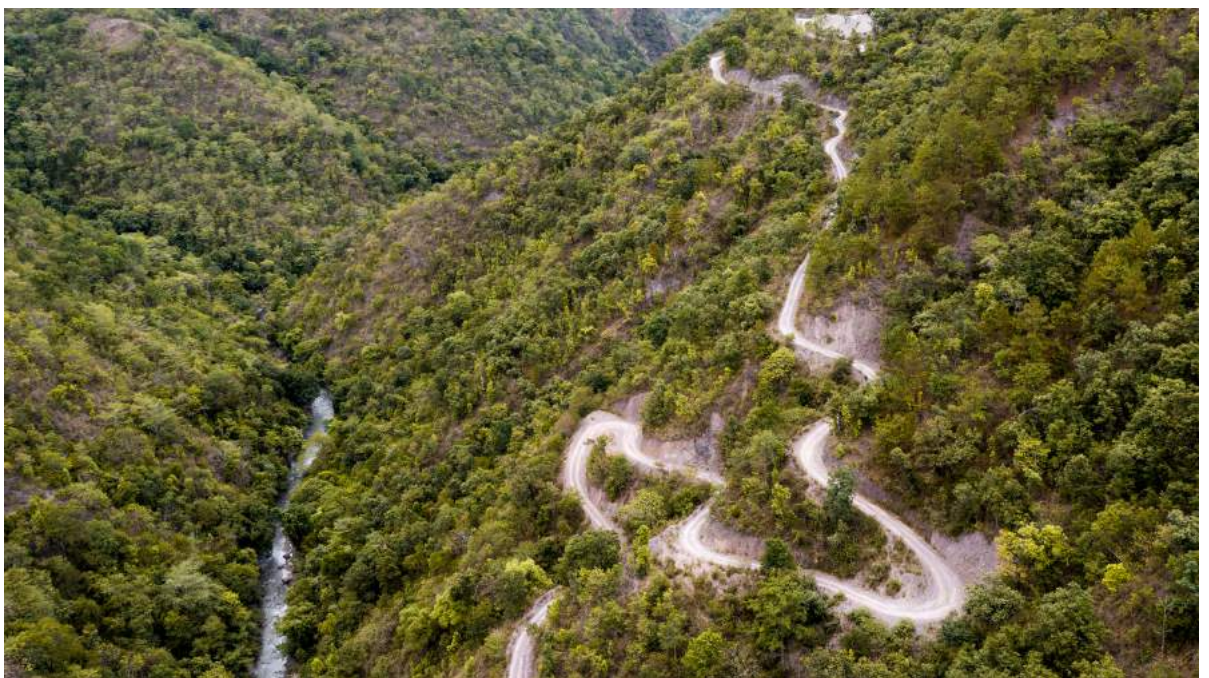
2017 年 6 月 17 日, 通向小江河新建的电站建筑的道路穿越了恐龙河自然保护区核心区。© 李玮 / 绿色和平
