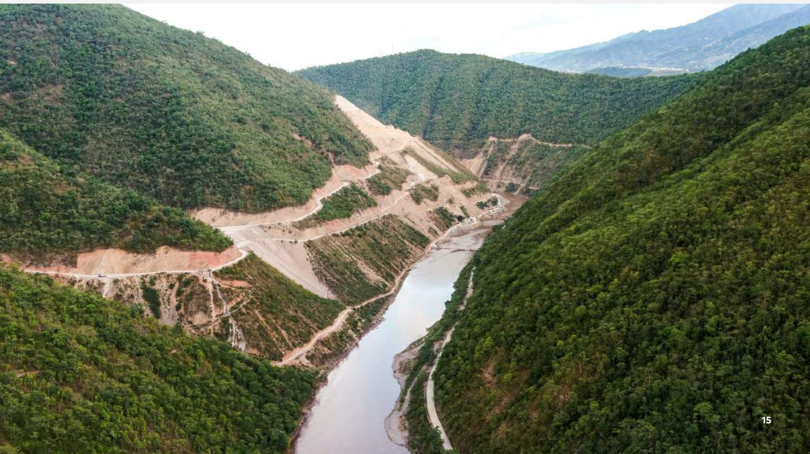
2017年6月17日，俯瞰云南省新平县戛洒江一级电站施工现场。 电站完工后将会淹没上游石羊江和绿汁江部分河滩和河谷低海拔森林。© 李玮 / 绿色和平
