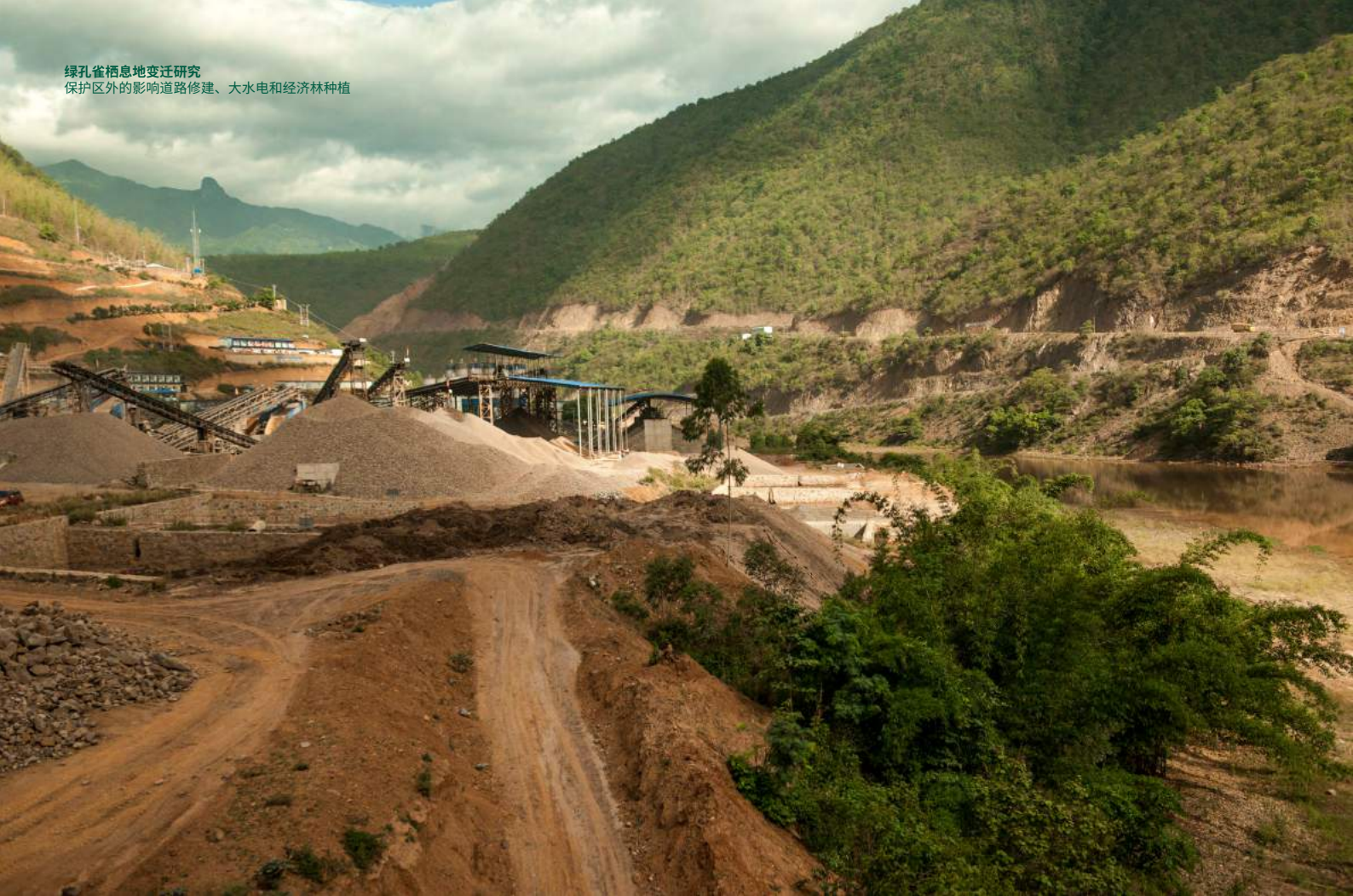
2017年6月17日, 云南省新平县戛洒江一级电站施工现场。 电站对山体的破坏、施工现场噪音以及完工后蓄水等人为侵扰因素都将对绿孔雀等珍稀动植物的生存造成威胁。© 肖诗白 / 绿色和平
