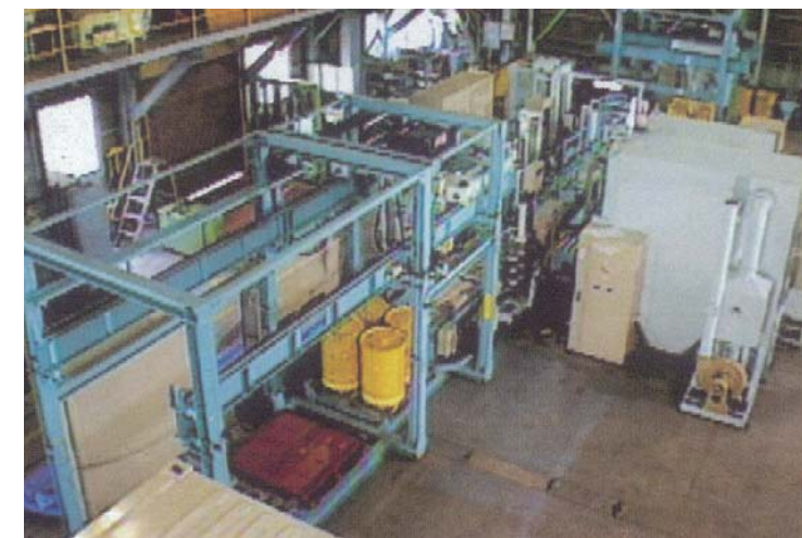
ドラム缶搬出検査設備
