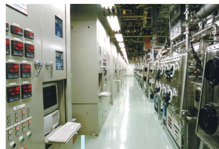
雰囲気制御グローブボックス(GB)設備 地下環境を模擬したホット試験装置 写真提供：日本原子力研究開発機構
