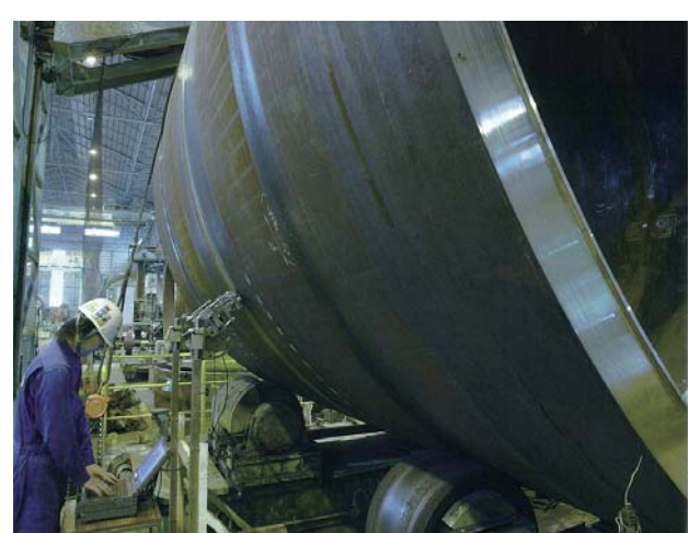
自動超音波探傷検査（周溶接部：TOFD）
