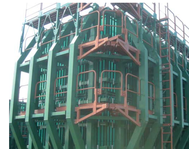
アルミ製システム型枠 埋設施設コンクリートピット打設用の型枠
