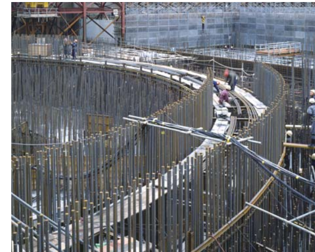
建設中の原子炉格納容器 高品質で信頼性の高い継手が得られるねじ節異形棒鋼 ネジコン
