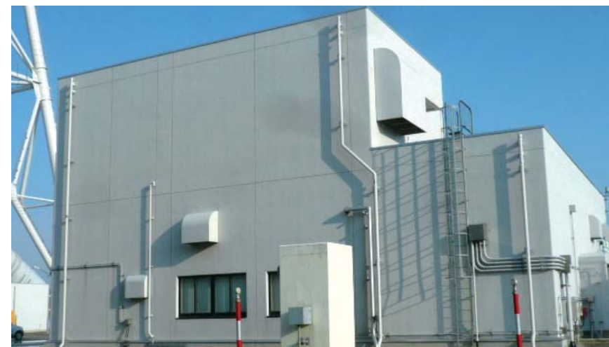
日本原燃 (株) 殿 試薬供給施設 (AR) 硝酸・TBP・ヒドラジン等の試薬を供給する施設
