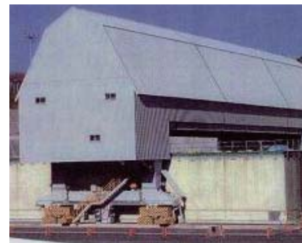
日本原燃殿 2号埋設クレーン 2号埋設施設にドラム缶をコンクリートピットに定置するクレーン
