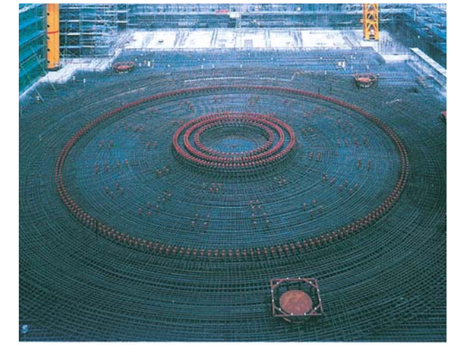
原子炉建屋のベースマット(鉄筋材) わが国異形棒鋼のパイオニア、ニーズを先取りするデーコン
