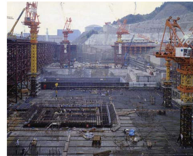
原子力発電所建設風景
