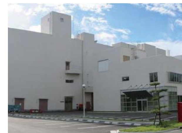
日本原子力研究開発機構 高減容処理施設の内、焼却設備、溶融設備 RI研究所施設等廃棄物を減容・固化する施設 写真提供:日本原子力研究開発機構
