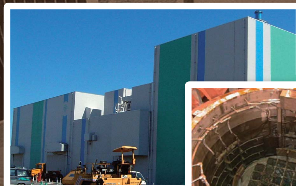
日本原燃(株) 使用済燃料輸送容器保守施設(f3) 使用済燃料(SF)輸送容器のバスケット内部の点検や除染等を行う
