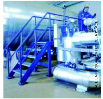
ドイツ初の地熱発電所。 発電所内で作業する職員。
