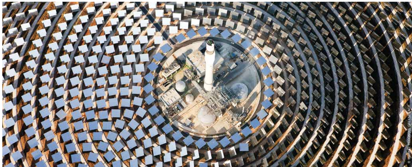
GEMASOLAR, スペインにある 1万5,000kW (15MW) の集光型太陽熱発電
