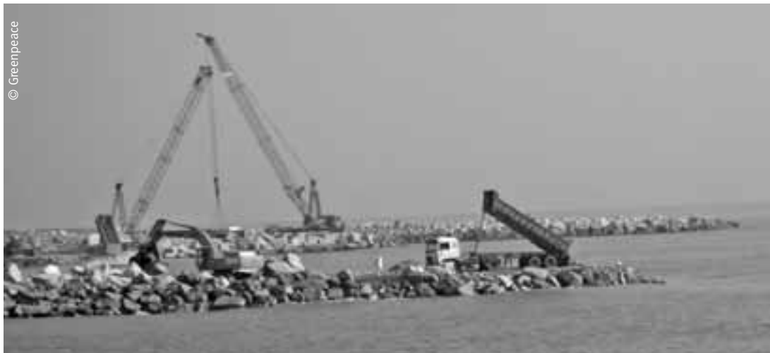
Obres del futur zoo a la costa de Barcelona.
