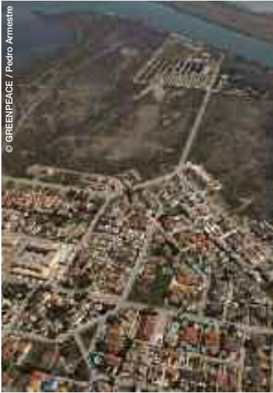
Urbanització al Delta de l'Ebre sobre zona inundable.
