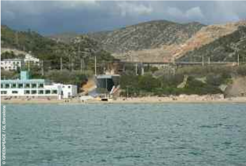
Diverses infraestructures i un hotel en el ENP de la costa del Garraf.
