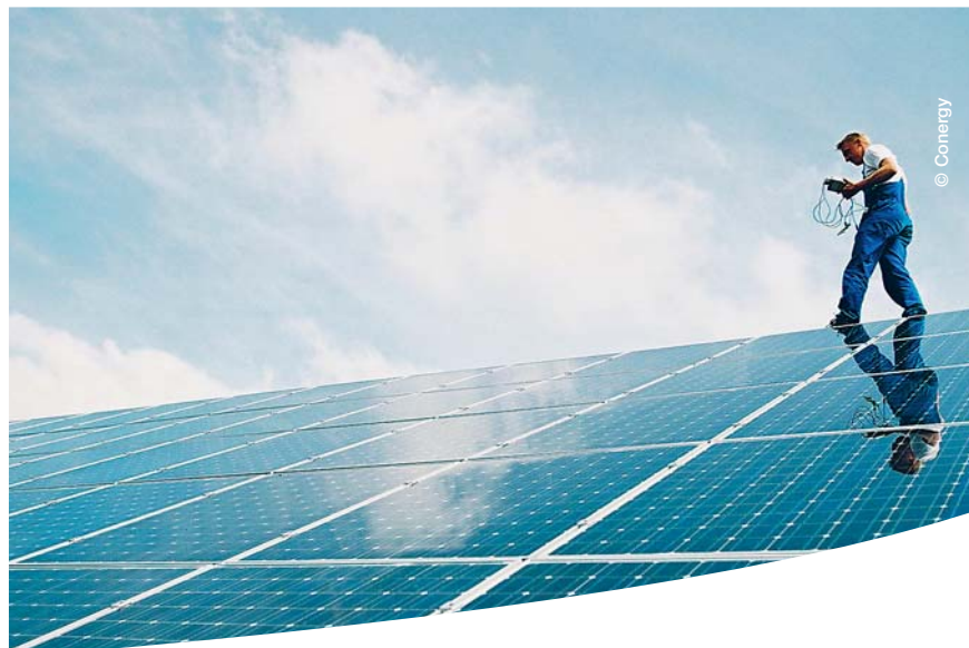
Instalación de un Sistema FV en un tejado
