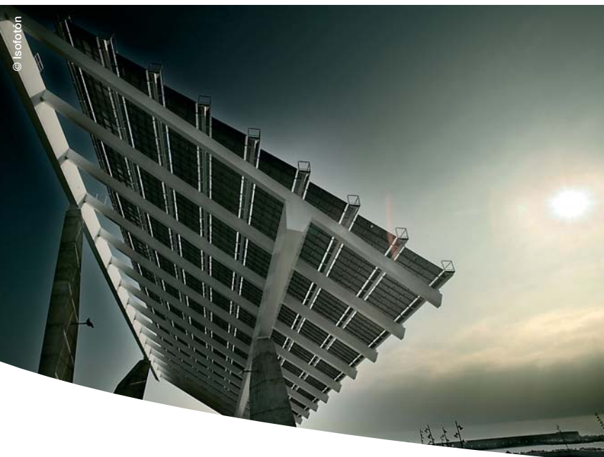
Pérgola FV en el Fórum de Barcelona
